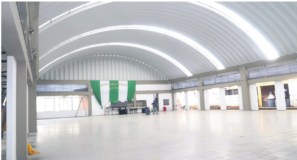
En el Huila se realizan en total 26 obras, de las cuales 22 ya están al 100%.
