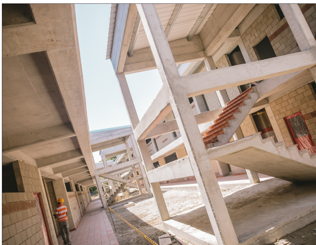
Los proyectos terminados en Magdalena representan 271 aulas entre nuevas, especializadas y mejoradas. El total de la inversión proyectada es de $60.574 millones, para beneficiar a 10.105 estudiantes. En la foto: IE Nuevo Amanecer con Dios.
