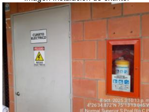
Imagen Instalación de extintor
