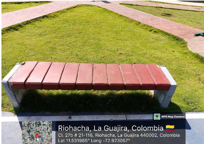
Fotos N° 13 y 14, Banca agrietada y sin espaldar.
