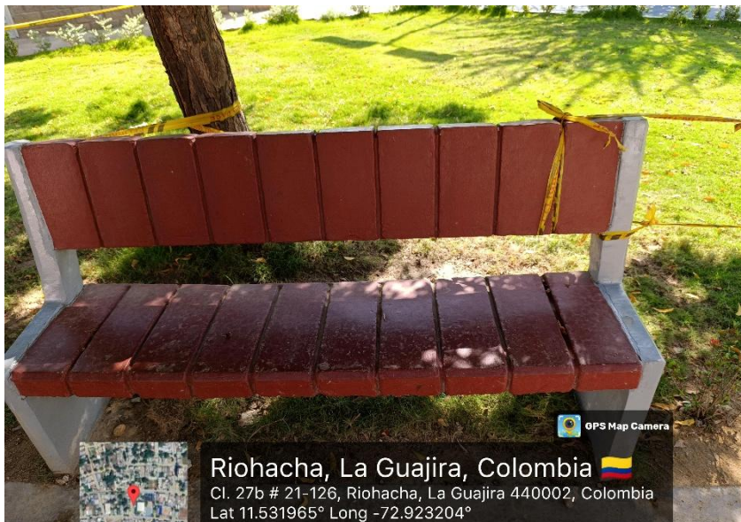
Fotos N° 7 y 8, Banca agrietada.
