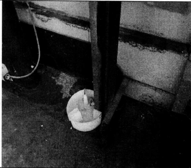
se evidencia corrosión de los perfiles y anclajes metálicos del foso del ascensor
