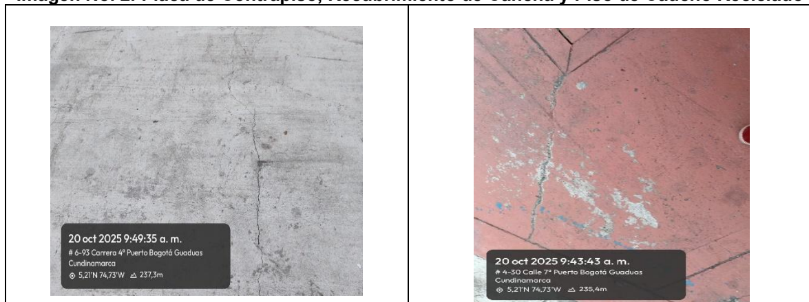
Imágen No. 2. Placa de Contrapiso, Recubrimiento de Cancha y Piso de Caucho Reciclado
