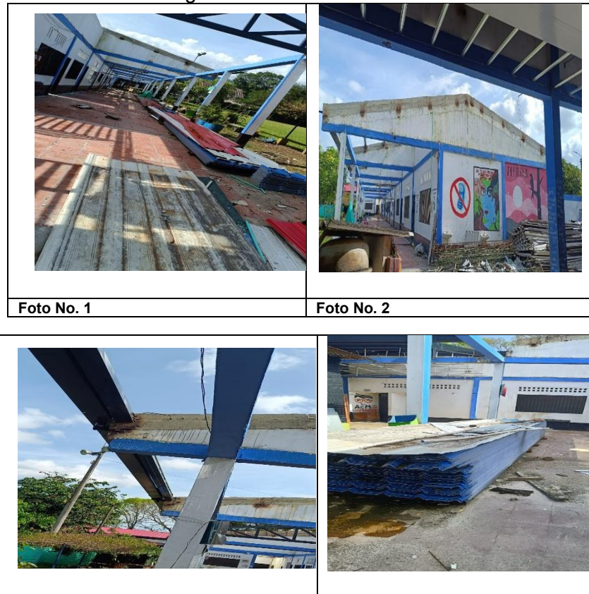
Imagen 1. Desmante de cubierta
