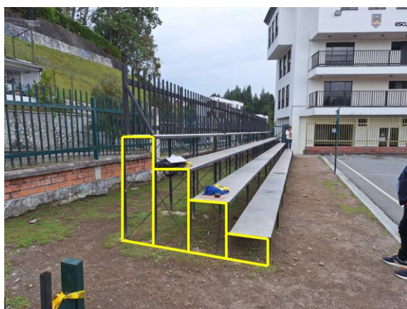
Concepto de pórtico en gradería, elementos verticales rigidizados transversalmente con viga de cimentación superficial y elementos horizontales aéreos (a cierta distancia del nivel de piso).
