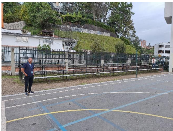
Concepto de pórtico en gradería, elementos verticales rigidizados transversalmente con viga de cimentación superficial y elementos horizontales aéreos (a cierta distancia del nivel de piso).
