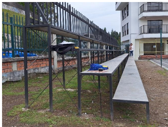
Concepto de pórtico en estructura de gradería, ausencia de viga de cimentación superficial en la mayor dirección de la estructura, como falencia para rigidizarla en dicha dirección.
