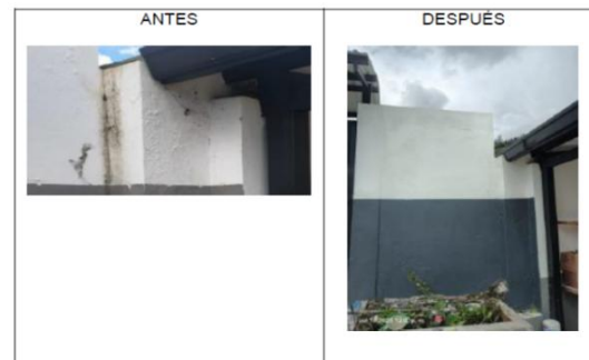
ITEM 17.1.2 SUMINISTRO E INSTALACION DE PINTURA EN VINILO TIPO 1 MUROS INTERIORES 3 MANOS
