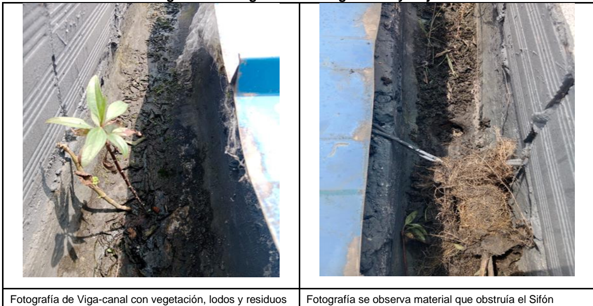
Figura 3. Imágenes de la Viga Canal y Bajantes
