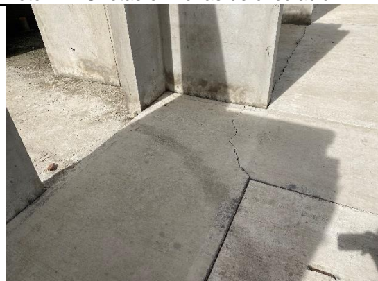
Foto 142 Grietas en zonas de circulación B1
