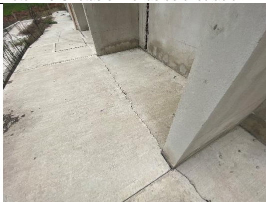
Foto 143 Grietas en zonas de circulación B1
