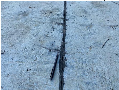
Foto 78 Sellado de dilatación de placa
