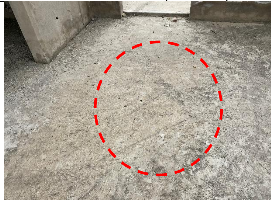
Foto 142 Grietas en zonas de circulación B1
