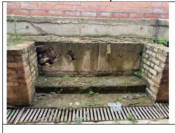
Foto 31 Concreto ciclópeo en obra
