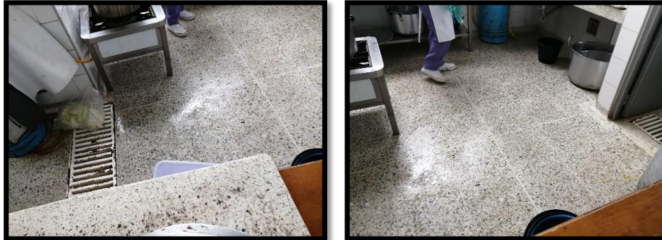
Fuente: Propia tomada durante visita técnica el 27 de abril de 2023.
