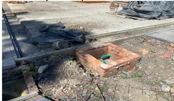
Foto 71 Cajas de inspección en construcción
