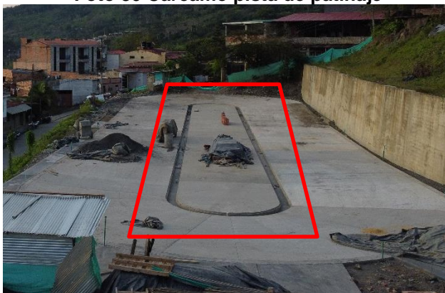
Nota: Perímetro de cárcamo en construcción
