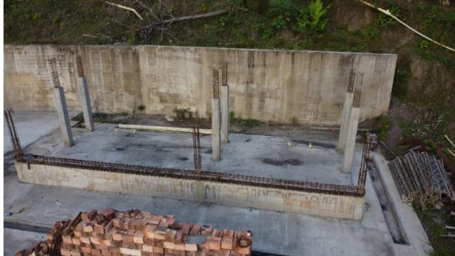
Foto 69 Vista superior de la zona de graderías y unidades sanitarias
