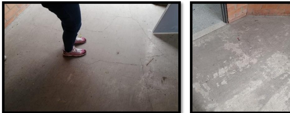
Fuente: Propia tomada durante visita técnica el 27 de abril de 2023.
