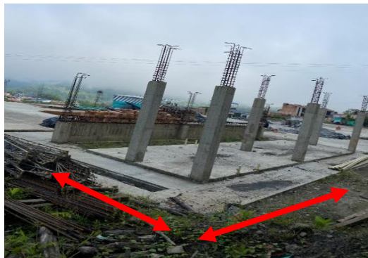
Foto 70. Placa sector unidades sanitarias
