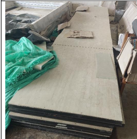
Paneles almacenados en mal estado
