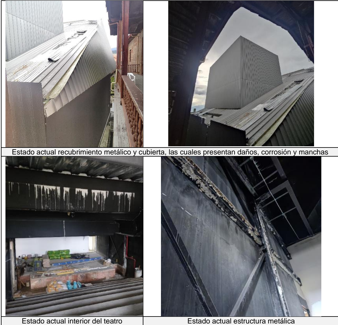
Imagen 1 Registro fotográfico Teatro Provincia de Cártama en el municipio de Támesis, Departamento de Antioquia
