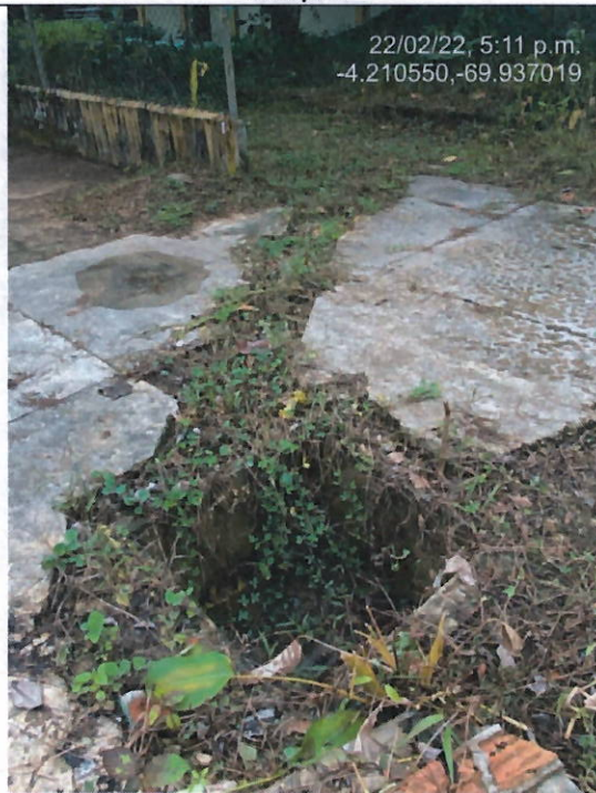
Excavación caja de inspección
