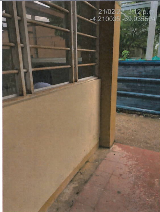
Pintura muros externos Bloque D (mejoramiento)
