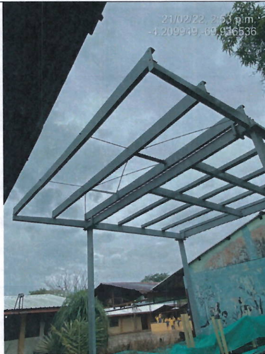
Perfilería cubierta Bloque Baños F
