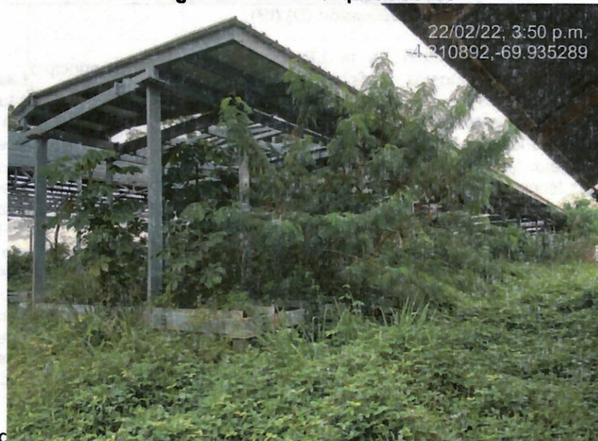
Imagen No. 22 Vegetación entre bloques nuevos
