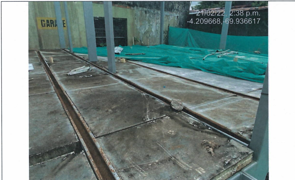
Bloque Baños I
