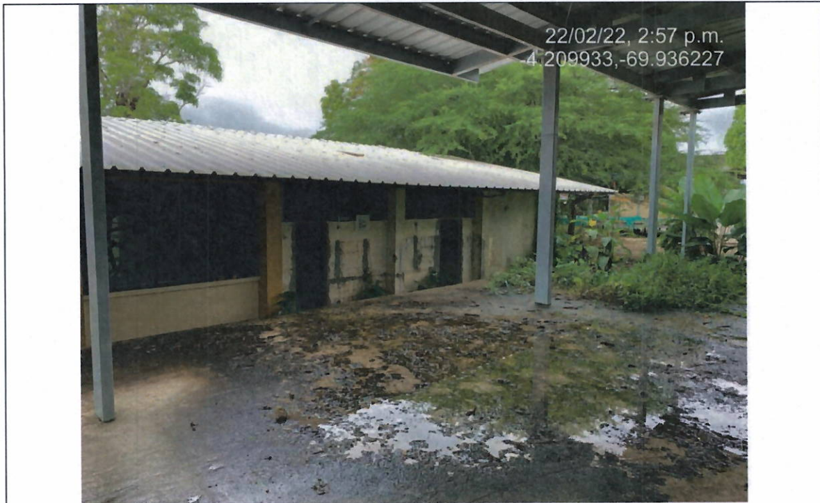
Placa Bloque A con humedad
