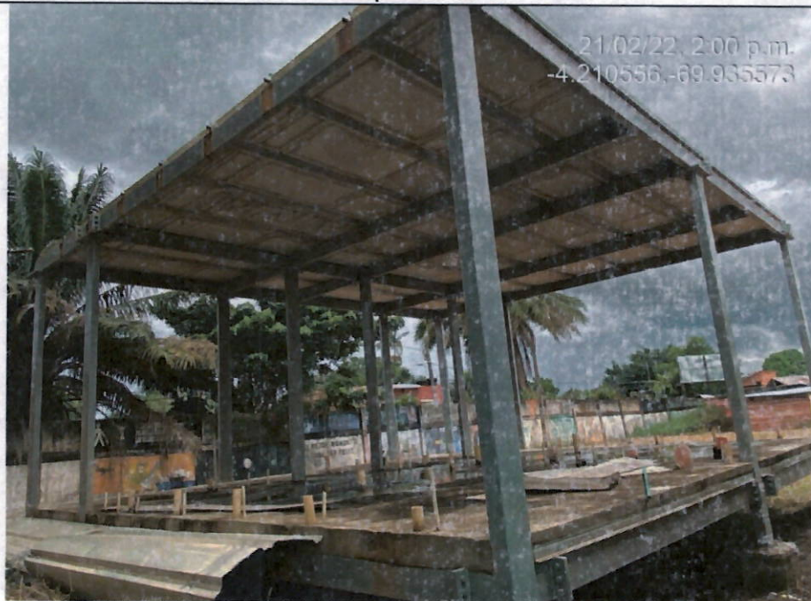
Bloque Baños G
