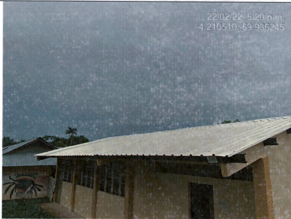
Cubierta Bloque Aula 1
