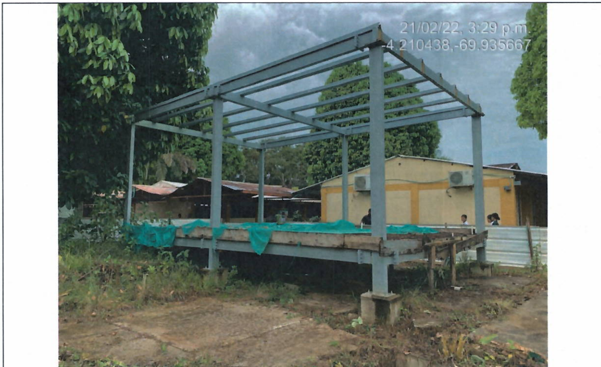
Bloque Baños H
