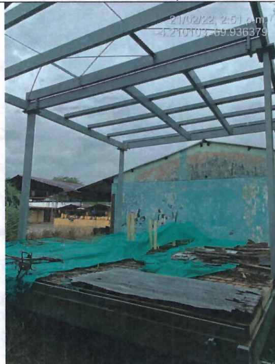
Perfilería cubierta Bloque Baños F
