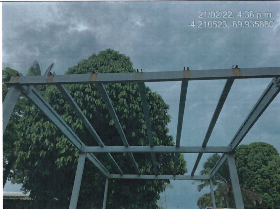
Perfilería cubierta Bloque Baños H
