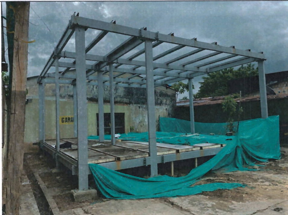
Bloque Baños I
