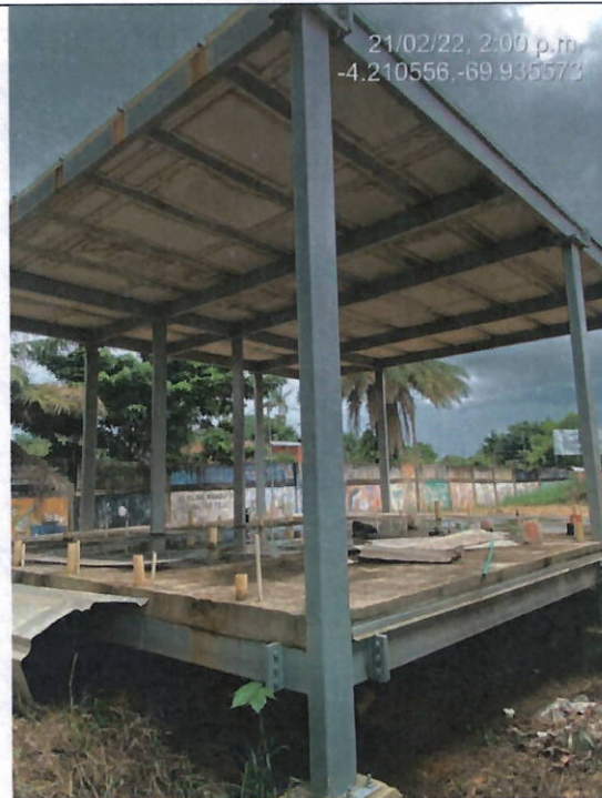
Bloque Baños G
