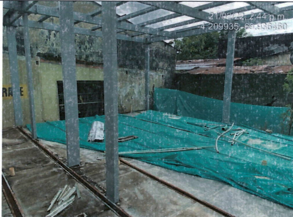
Bloque Baños I
