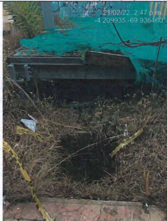
Excavación caja de inspección
