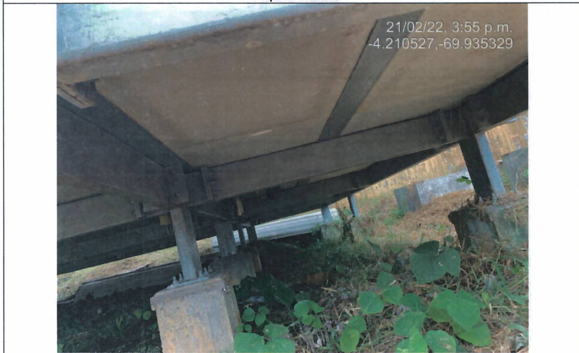
Bajo placa Bloque Baños G
