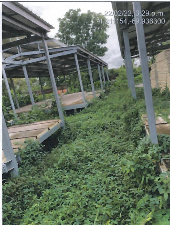
Vegetación entre bloques
