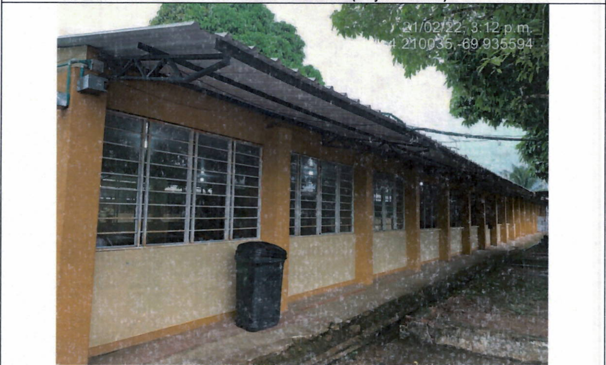
Pintura muros externos (mejoramiento)
