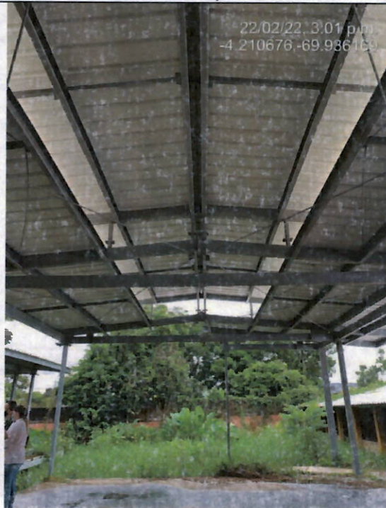
Cubierta Bloque A
