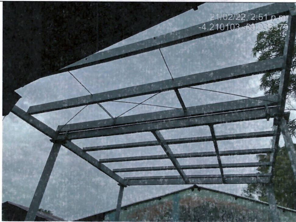
Perfilería cubierta Bloque Baños F
