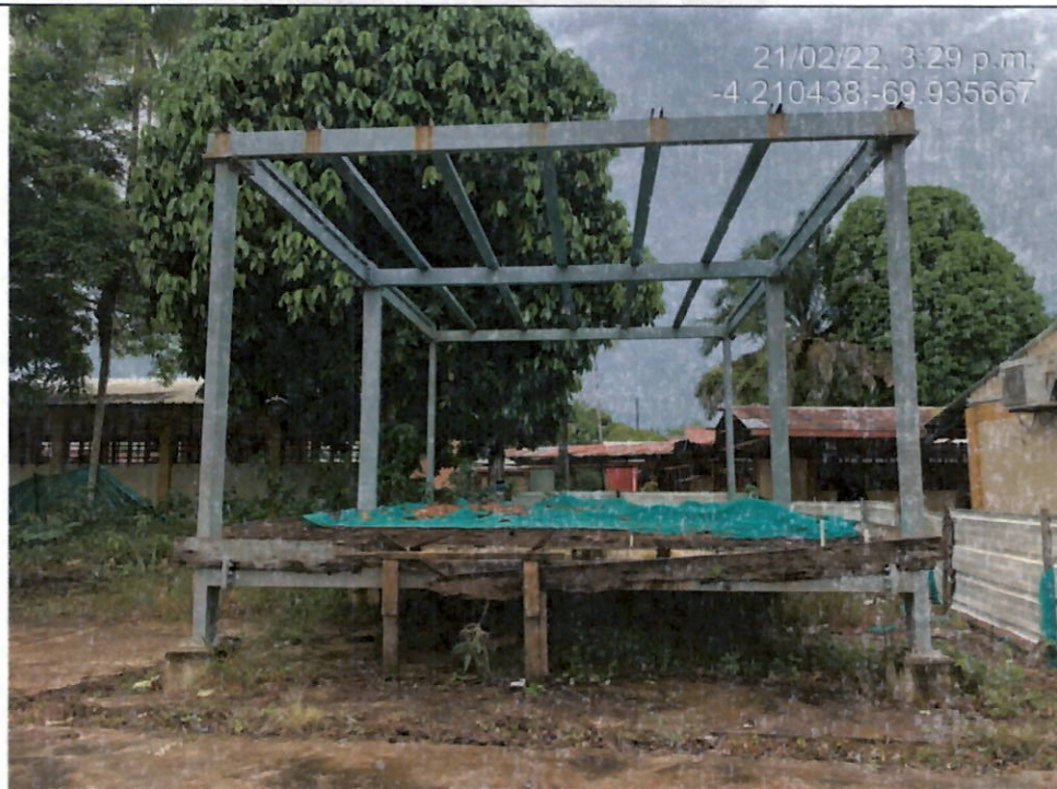
Baños Bloque H
