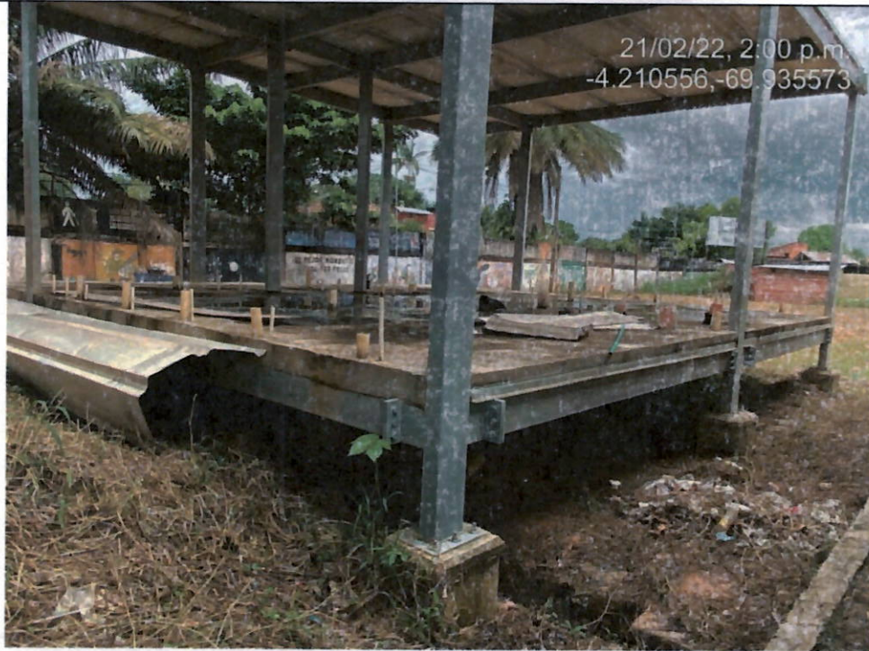
Bloque Baños G
