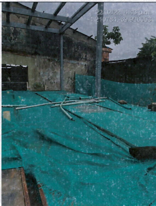
Baños Bloque I
