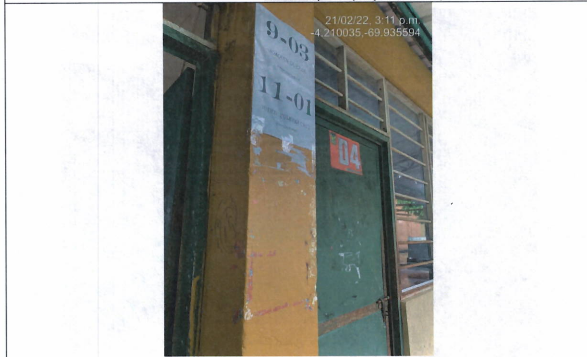
Pintura muros externos Bloque D (mejoramiento)
