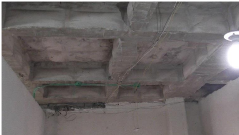
Foto No. 51. Techo cocina IE Inobasol – Sede 3 de Soledad
