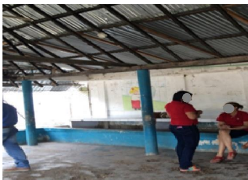
Foto No. 89. Área del Comedor
