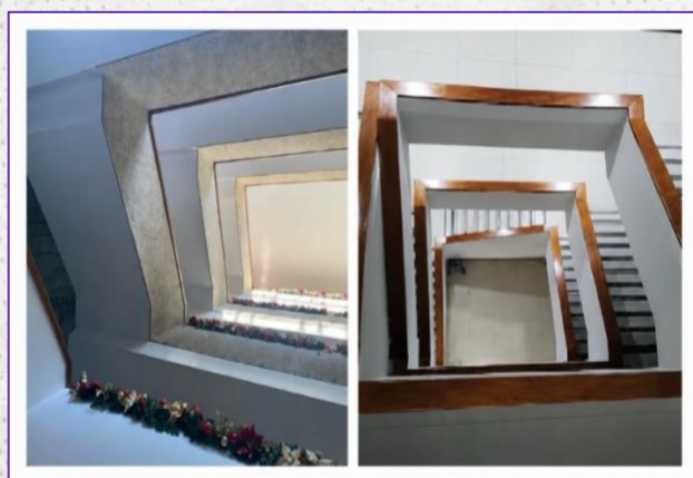
Ilustración 31. Adecuación del punto fijo de las escaleras del costado occidental
