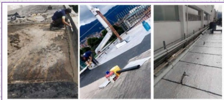
Ilustración 37. Impermeabilización de la cubierta
