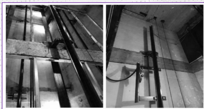
Ilustración 30. Adecuación de la zona del foso de los ascensores para cumplimiento normativo
