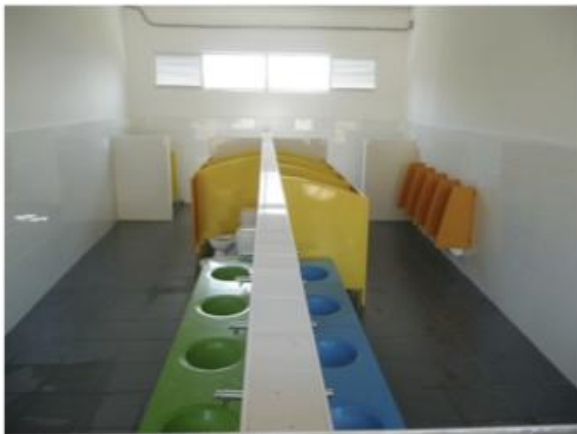
BATERIA DE BAÑOS
